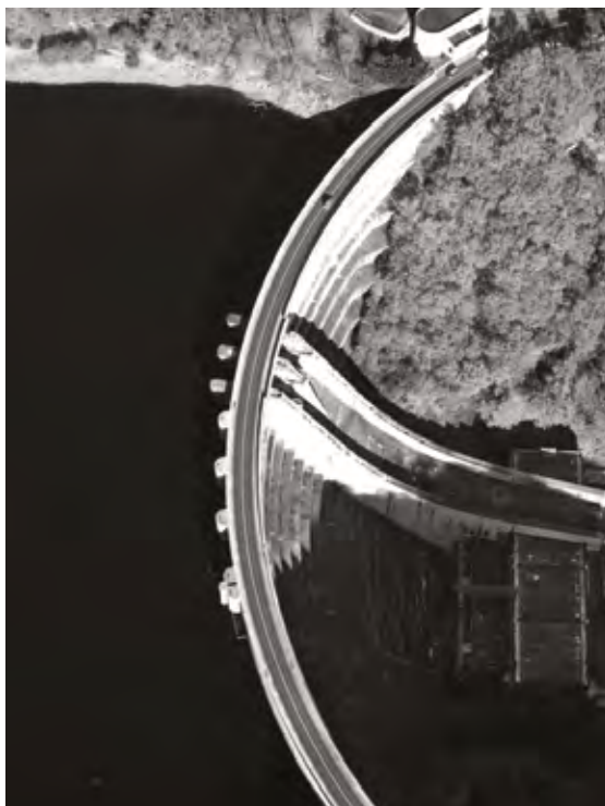
Barrage de Bort-les-Orgues
