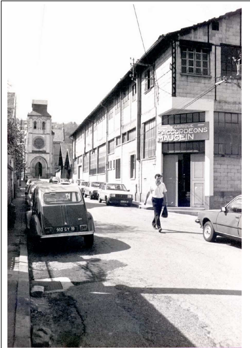
L'entrée de l'usine (1982) – Arch. dép. de la Corrèze, 1 Num 179.
