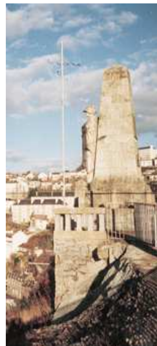
Tulle : le monument aux morts, en 1988. Arch. dép. de la Corrèze, 2 Fi 3124.
